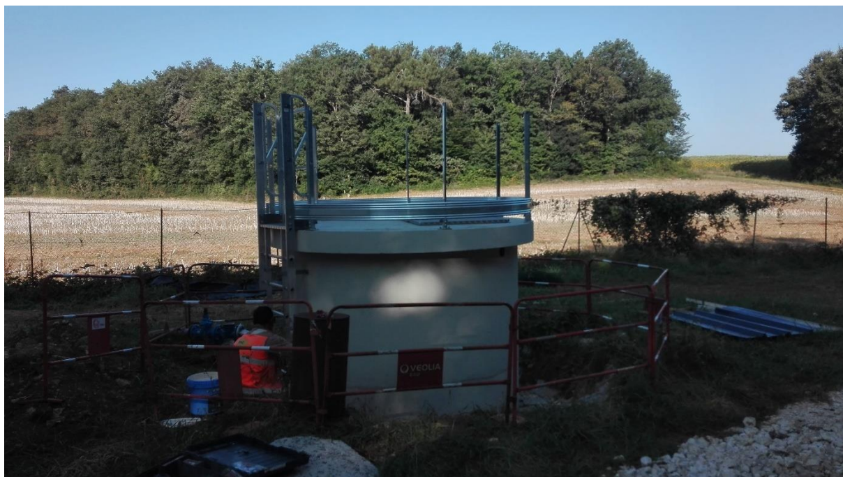
Photo 9 : Vue sur la tête de forage, au 25/08/2021
