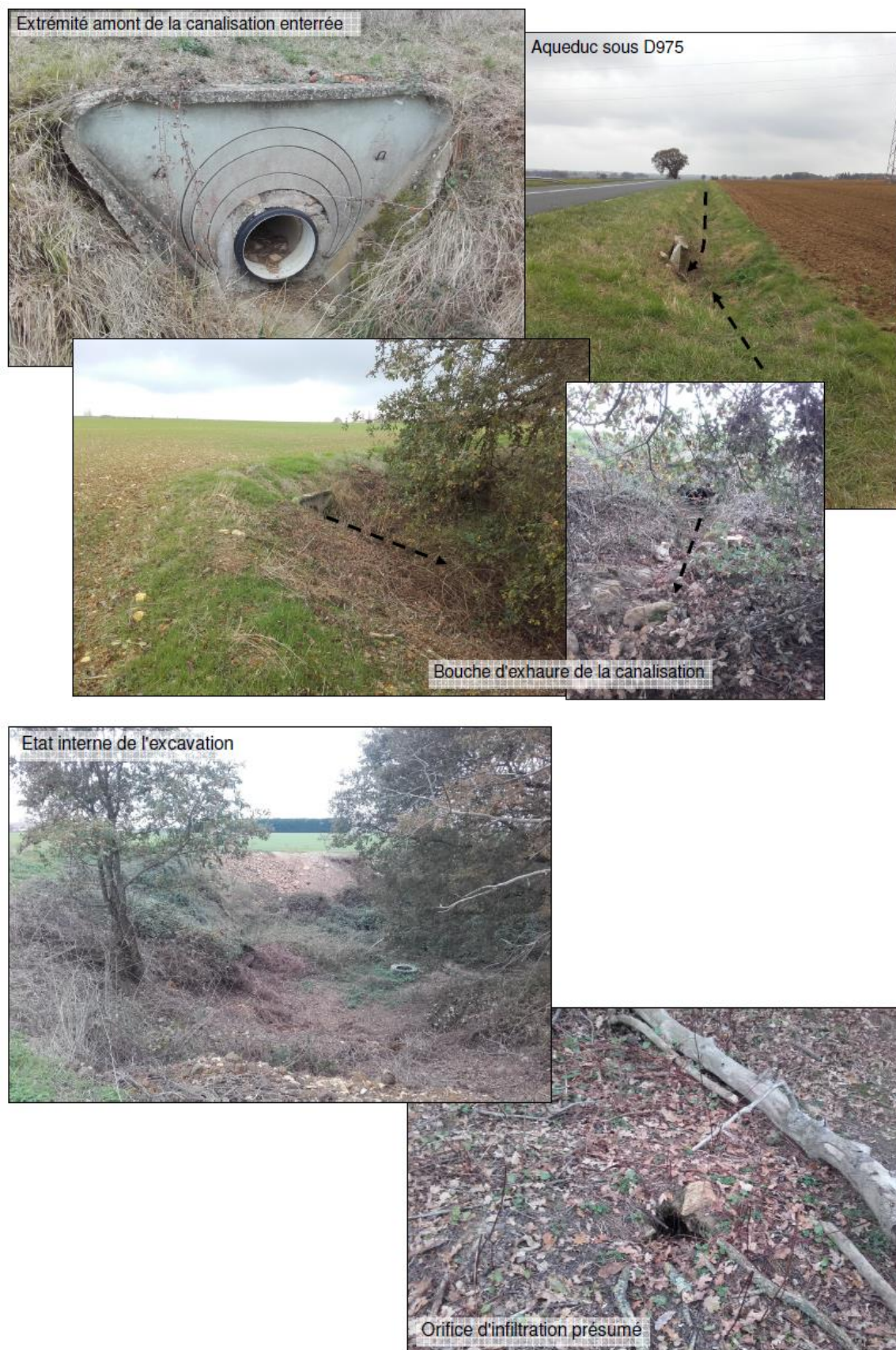
Photo 6 : Description de l'ancienne marnière connectée hydrauliquement aux fossés de la RD 975 (source : rapport SETHYGE – 2019)
